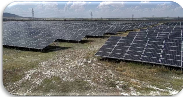
Konya, GİTAŞ-1 - 14 MWp
